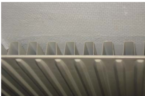
Figur 3.3. Panelradiator med fastsvetsade konvektionsplåtar på baksidan.
