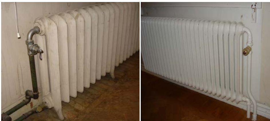
Figur 3.1. a) Äldre sektionsradiator av gjutjärn.
