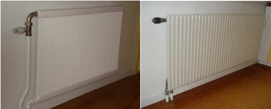
Figur 3.2. a) Radiator av veckad stålplåt.
