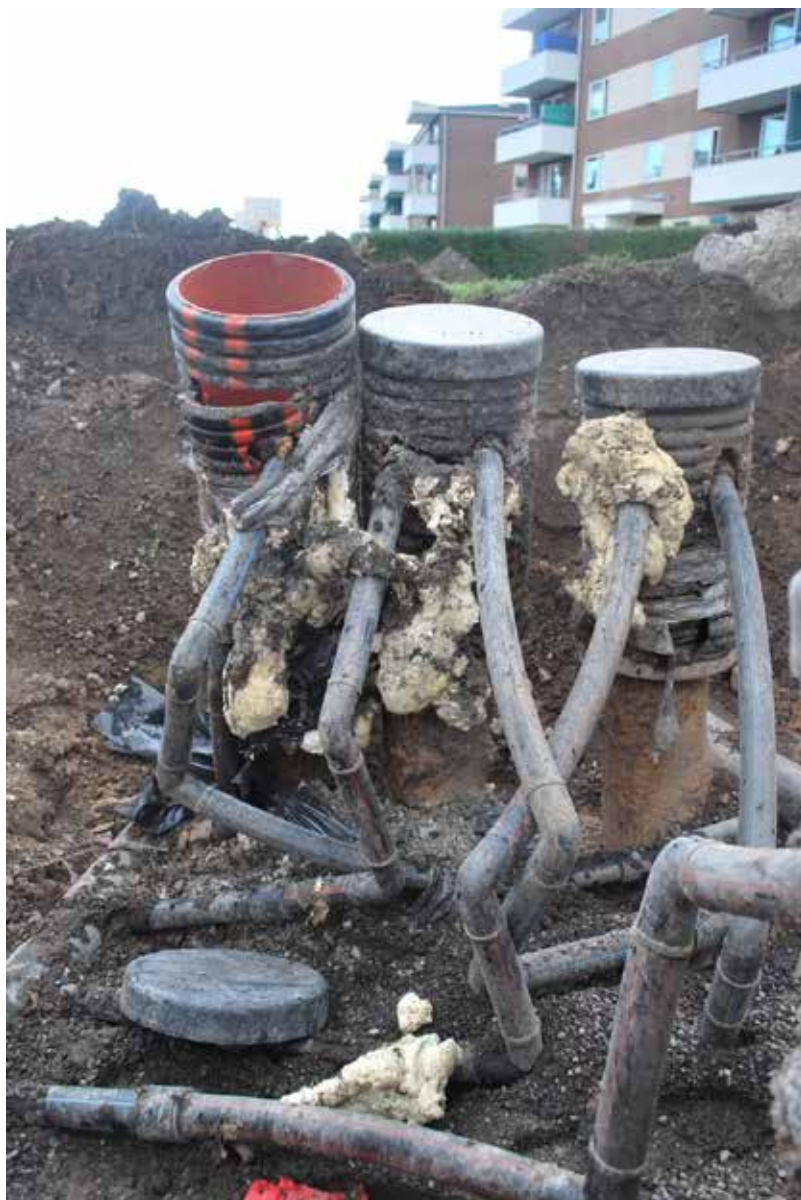
Figur 59. Installation som inte är fackmannamässigt utförd. Ständiga läckage!
