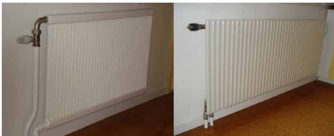
Figur 36 a) Radiator av veckad stålplåt.
