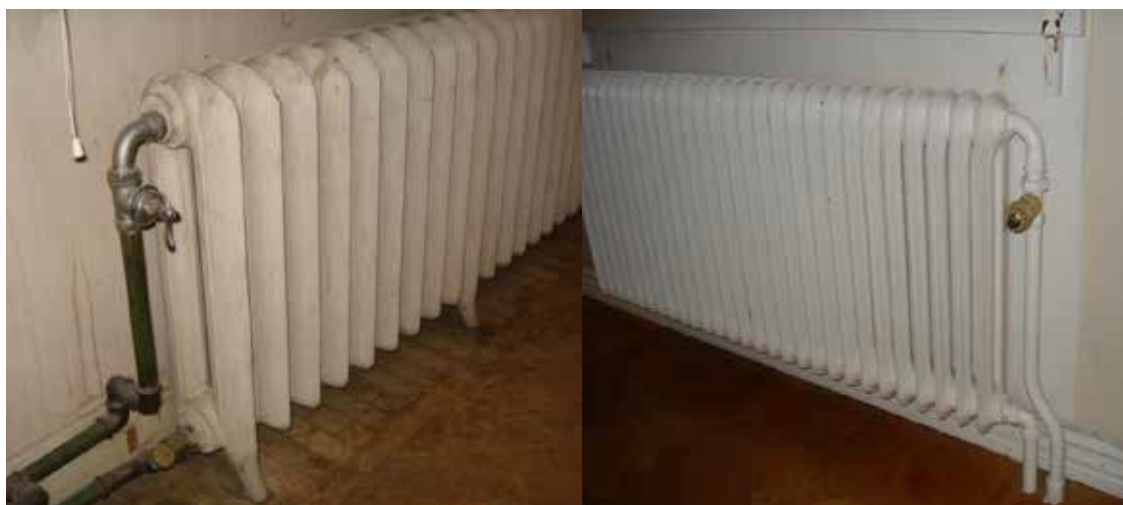
Figur 35 a) Äldre sektion radiator av gjutjärn.
