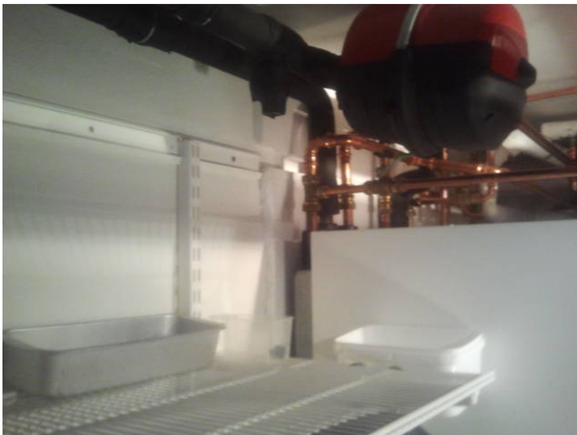
Figur 61. Bristfällig isolering på kalla rör inomhus. Ger kondens. Fram med droppskållarna!
