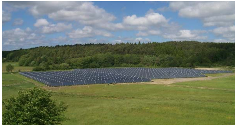
Under perioden 1999-2001 uppfördes ett par större solvärmeanläggningar, bl.a. den hittills största svenska anläggningen med 10 000 m 2 solfångare (7 MWth) - Kungälv Energi AB.
