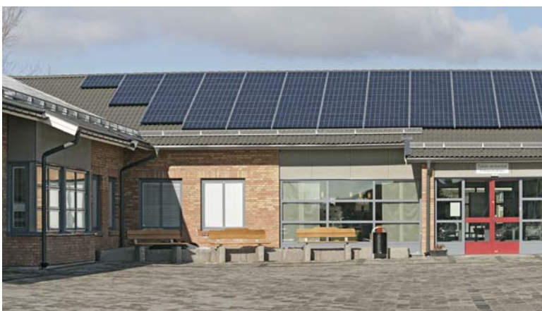
Solcellsanläggning med 500 m 2 (ca 60 kWe) på Fjärås vårdcentral - EKSTA Bostads AB (2005).
