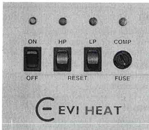
Figur 4 Larmlampor med resetknappar och lågspänningssäkring
