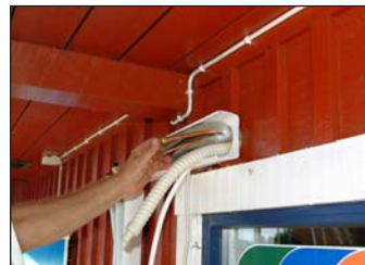
24. Böj försiktigt rören så att de kommer rätt i längdriktningen.
