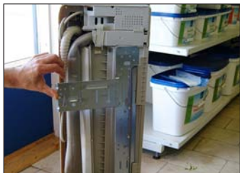
1. Börja med att plocka av plåten som inledelsen skall hängas upp på.
