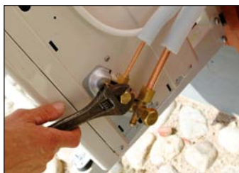
34. Skruva av muttrarna till vätskerören. Bakom dessa muttrar finns kranarna där ni skall släppa på gasen.
