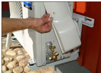
22. Tag av skyddspanelen till el- och gaskopplingarna.
