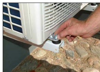
20. Skruva fast utledelsen och drag åt. Ej för hårt! Då kanske ni skadar gummit i dämparna.
