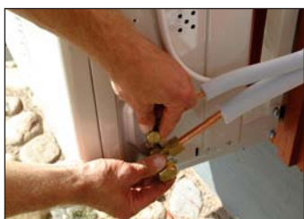
37. Skruva tillbaka muttrarna för vätskerören.
