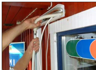
27. Fäst dräneringsslangen och låt den följa rör- och strömkabelpaketet. Ni avslutar dräneringsslangen på lämplig plats.
