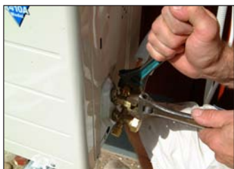
29. Vi visar även i denna bild hur ni måste hålla emot för att inte knäcka hela anslutningspaketet! Mycket viktigt!
