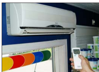
39. El som driver värmepumpen måste vara kopplad. Det gör ni i utedelen. Därefter kan ni starta värmepumpen.
