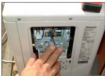
33. Montera strömkablarna som kommer från innedelen enligt ruta 6. Jord till jord. 1=brun, 2=svart, 3=blå. Skruva tillbaka plåten.
