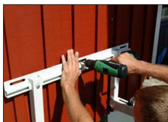
15. Sätt upp konsollen. Borra hålet för mittskruven.
