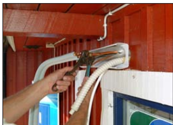
25. Koppla rören som skall gå till utedelen. OBS! Ni måste dra muttrarna ordentligt. Använd mycket kraft! Annars risk för läckage!
