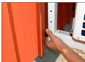
19. Justera gummi/skruvarna på konsollens baksida.
