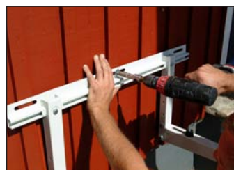
16. Skruva fast mittskruven. Använd lämpliga fästsruvar när ni monterar er konsoll.
