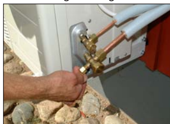
35. Skruva fast mutter till vacuum-pumpssugningsröret.
