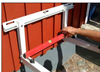
17. Väg in konsollen med vattenpass. Borra och skruva därefter fast de två andra fästsruvarna.
