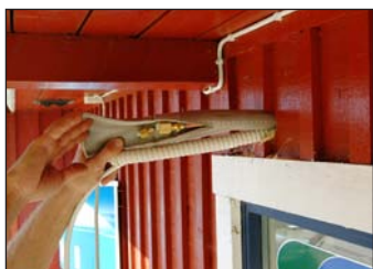
9. Här ser ni hur rör - och strömkabelpaketet kommer ut genom det borrarade hålet.
