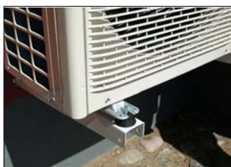
18. Häng upp utledelsen. Fixera de främre dämparna så att ni kan passa in de bakre dämparna i maskinens djupled.
