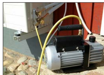
32. Vakuumsug under en timme. OBS! Koppla av slangen vid värmepumpen när vacuum-pumpen fortfarande går efter en timma! (Då kan ni inte få baksug!)
