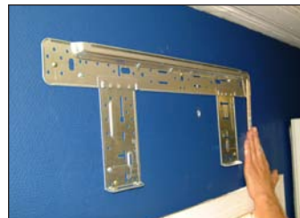
4. Markera ut centrum för hålet som skall borraras. Det finns två stjärnor på plåten som visar linjen på centrum.
