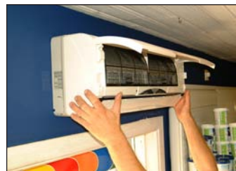
8. För ut rör- och strömkabelpaketet genom hålet och häng upp inledelsen. Nu är den på plats!
