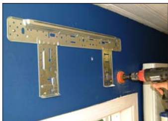
5. Borra hål i väggen. 65-70 mm. Obs! Borra hålet med lite fall mot utsidan pga att dräneringsslangens vattenflöde
