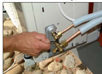
36. Släpp på gasen med sexkantnyckel 4. Öppna kranarna för fullt.
