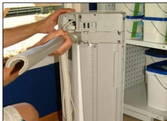
2. Böj försiktigt ut rörsatsen.
