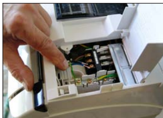
6. Montera en 4-ledad, 1,5 kvadrat strömkabel. Jord till jord. 1=brun, 2=svart, 3=blå. Strömkabeln går sedan vidare till utledelsen.
