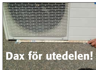
12. Montera er konsoll enligt bifogad beskrivning. Mät därefter ut cc mellan utledelens fötter.
