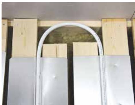
11. Exempel på korrekt vändning av röret.
