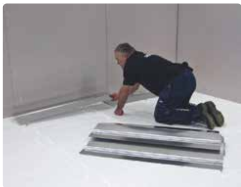
5. Montera värmeavgivningsplåtarna i golvvärmeskivornas spår.
