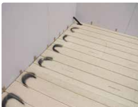
14. Markera var röret ska vända på spånskiivorna för att underlätta fräsningen.
