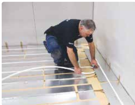
16. Se till att röret ligger i botten på spåret.
