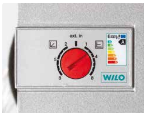
Bild 96: Justering av cirkulationspump
