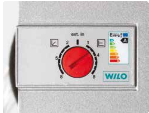
Bild 93: Justering av cirkulationspump
