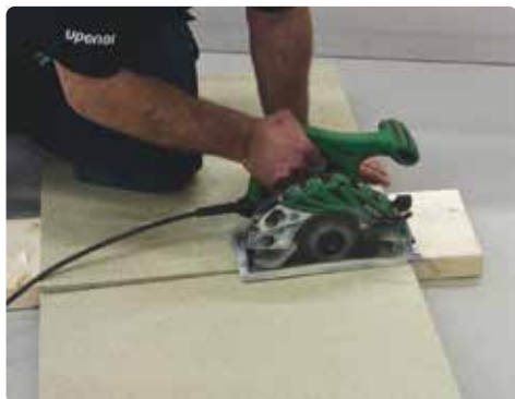
5. Kapa kassetterna, på både bredd och längd, med en cirkelsåg. Kassetten kapas med undersidan upp.
