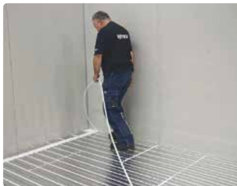
10. Montera genom att trampa ner röret i spåret (bilden visar rördragning i framledningen)
