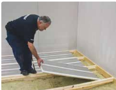
4. Lägg kassetterna cirka 30 cm från väggen för att få plats för rörets vändningar. Kassetterna ska ligga med minst 10 mm och max 100 mm mellanrum.
