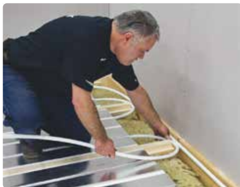
11. Vändoglorna kan hållas på plats med ett skruvband.
