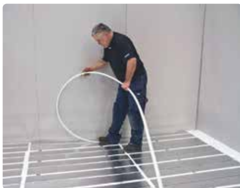
8. Montera röret i spåren.
