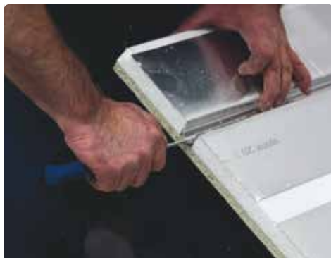
6. Avgrada plåtarna där röret ska ligga.
