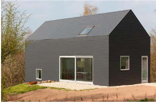
Bild 6. Referensbild, tak- och fasadbeklädnad av fibercementskivor.
