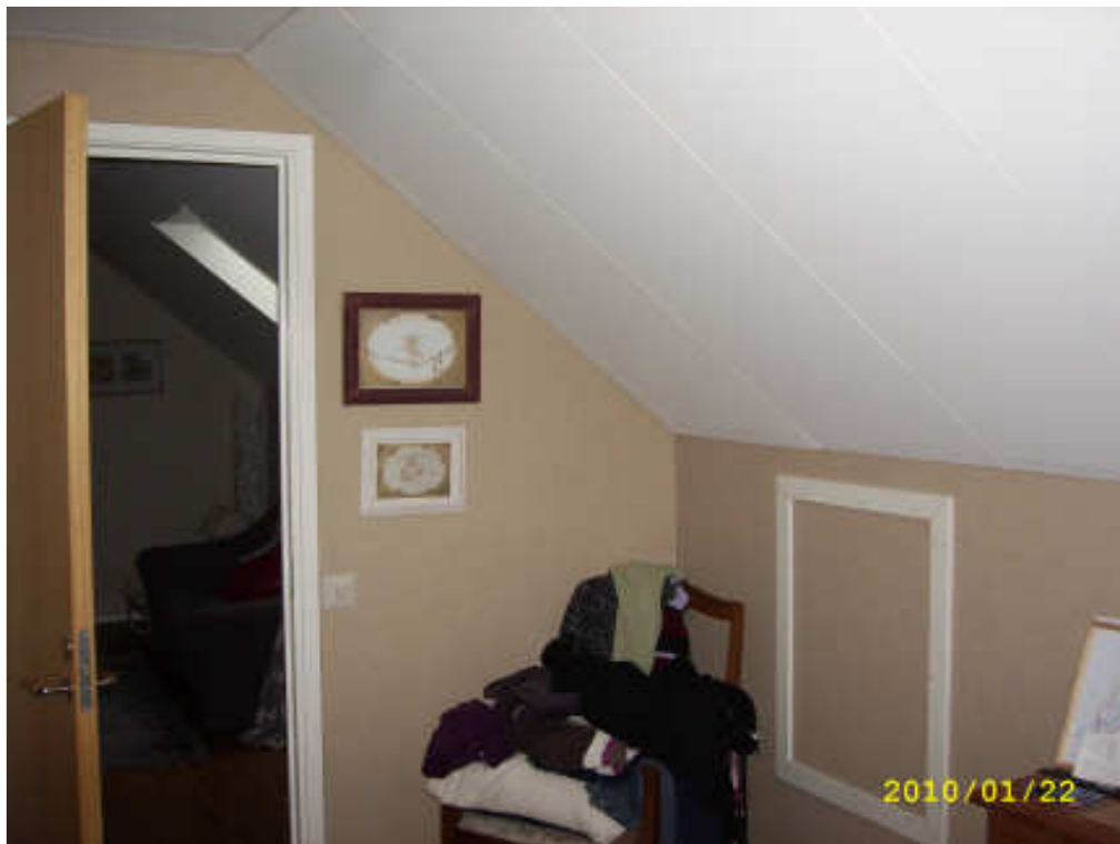
Lucka ut till sidvind samt snedtak med 15 cm gullfiber
