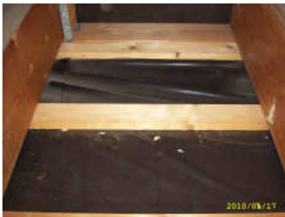
Ångspärr under, ej tejpade skarvar
