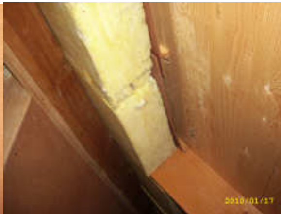
Isolering i tak med luftspalt
