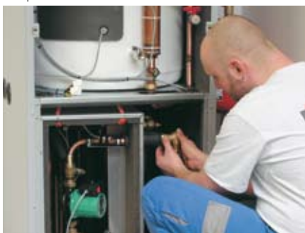
Tilkobling av modulboksen
